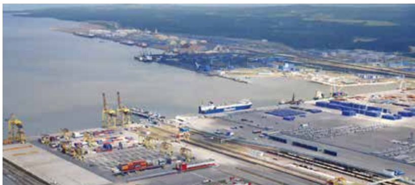
Строящийся интегрированный комплекс по переработке и сжижению природного газа в районе морского порта Усть-Луга будет включать и крупный метанольный завод
