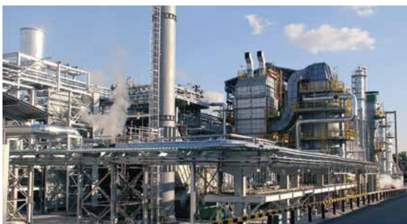
ОАО «Щекиноазот». Здесь с 2011 г. действует современное конкурентоспособное производство метанола по технологии Haldor Topsoe (Дания) мощностью 450 тыс. т/год
